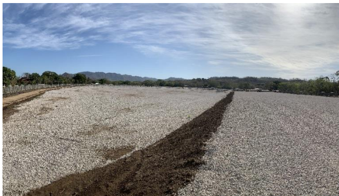
Figura 8 Colocación de piedrilla sobre toda la superficie del AP Marzo 2022
