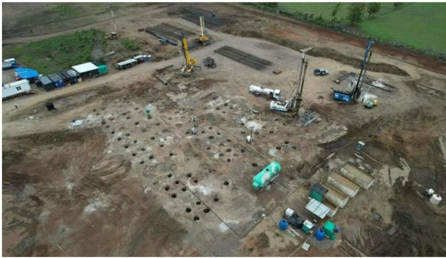
Figura 9. Construcción de pilotes.
