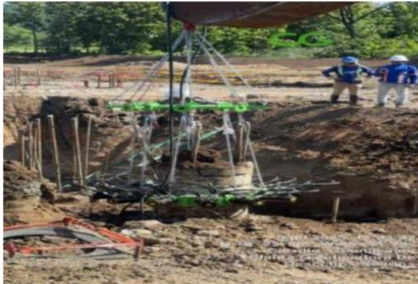
Figura 10. Descabezado de pilotes
