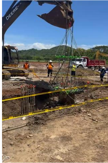
Figura 8. Construcción de pilotes.
