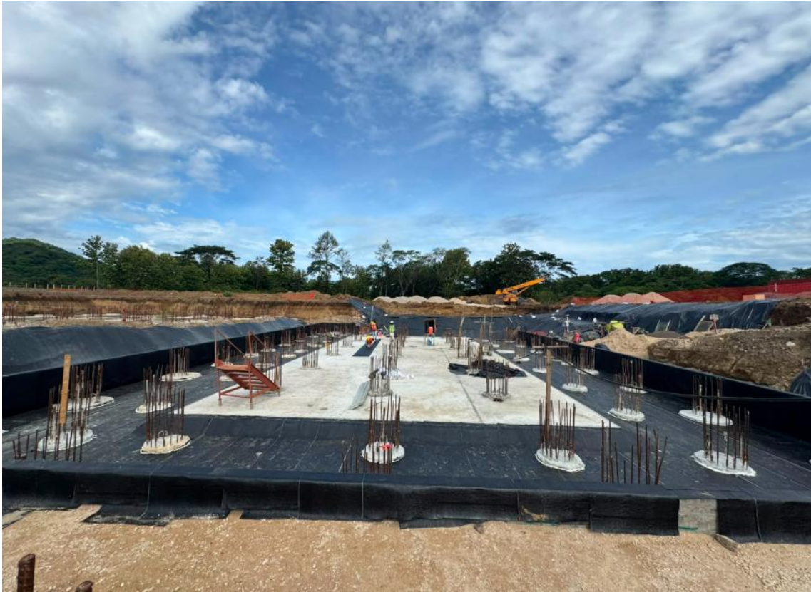
Figura 15. Impermeabilización Junio de 2026.
