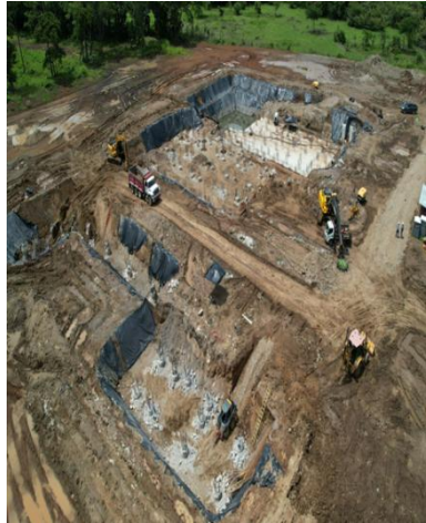
Figura 12. Excavación en fase 2 del proyecto
