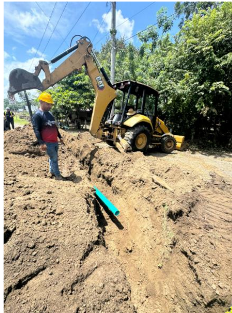
Figura 28. Colocación de tubería de 4 pulgadas.
