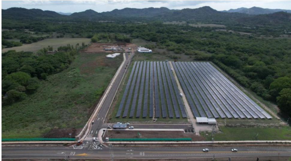
Figura 6. Zona sur de ampliación de ruta 21
