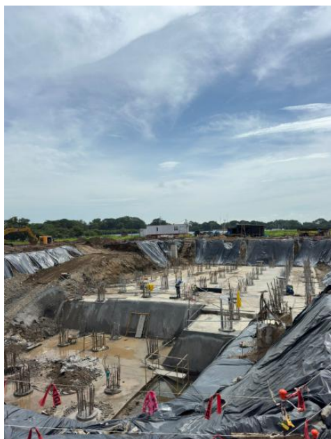
Figura 11. Zona de fosa de residuos y piscina de lixiviados
