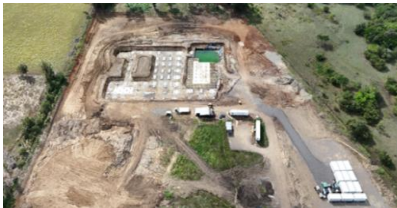
Figura 9. Excavación del proyecto. Noviembre 2025
