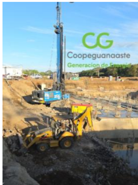
Figura 14. Subsane de pilotes Enero de 2025.
