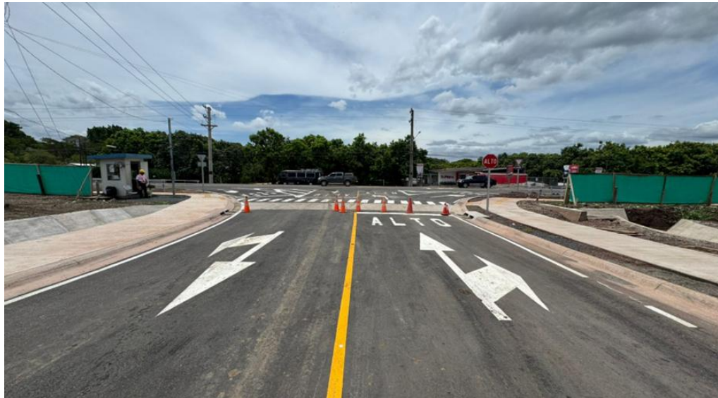
Figura 2. Finalizadas labores de Pintura. Mayo 2026.
