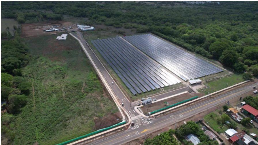
Figura 5. Obras de ampliación de ruta 21
