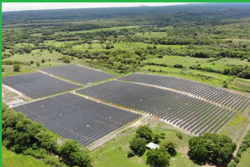
Parque Solar Valle Escondido
