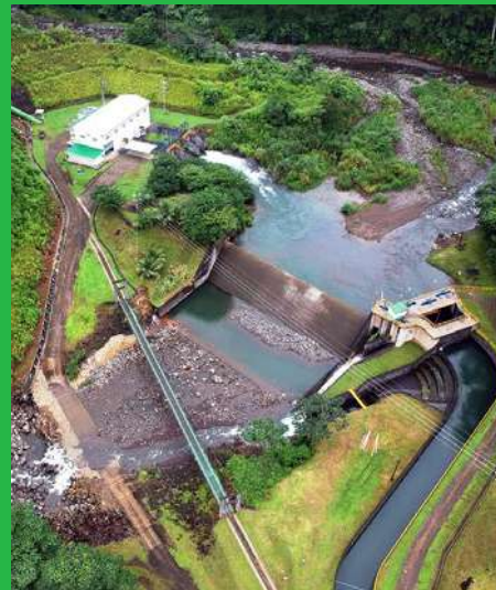
Central Hidroeléctrica Bijagua
