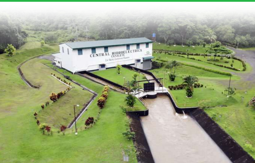
Central Hidroeléctrica Canalete
